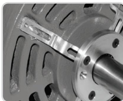
Installazione della resina epossidica conduttiva AEGIS® EP2400
